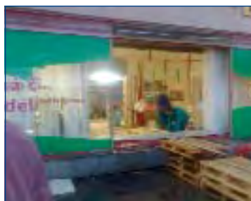
Čas 15.56 Montážní otvor je připraven a akce může začít
